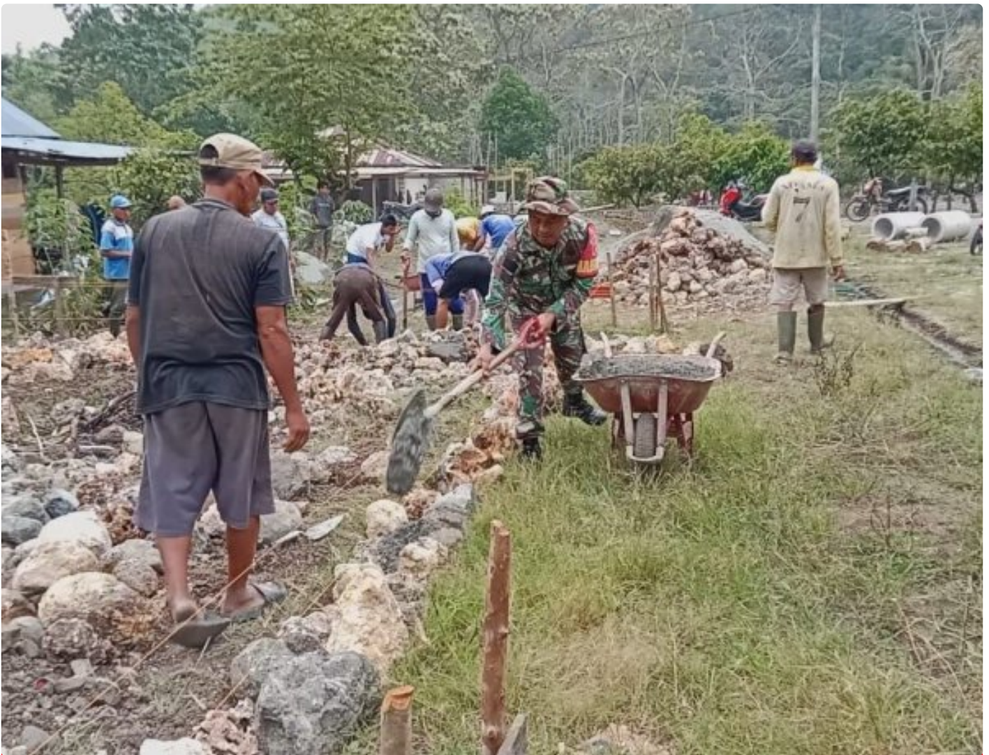
Gotong royong bangun pondasi rumah warga
